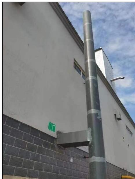
图 7 低氮燃烧装置+12m 高排气筒
