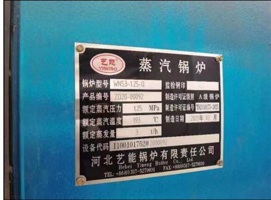
图 10 3t/h 燃气蒸汽锅炉
