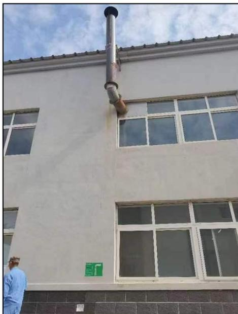
图 6 低氮燃烧装置+9m 高排气筒
